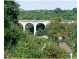
Das Beke-Viadukt ist das Wahrzeichen von Altenbeken.
